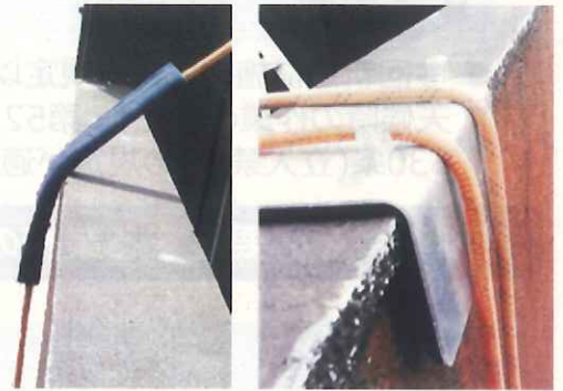
切断防止措置の例 (置き型養生) ▲
