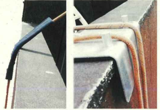
切断防止措置の例 (置き型養生) ▲
